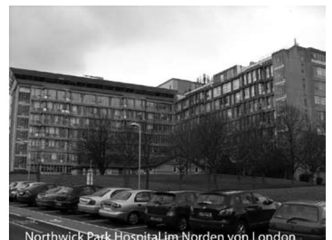
Northwick Park Hospital im Norden von London
